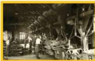
Strutture di carico e invio al fronte; parte interna
