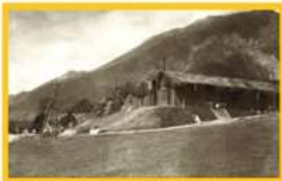
Strutture di carico e invio al fronte; parte esterna
